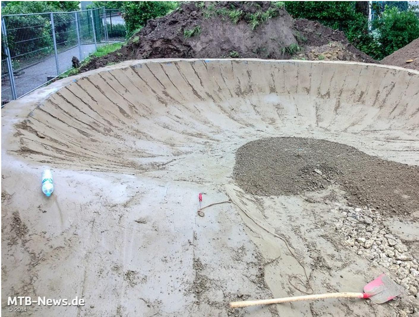
[#5](#) Einige Erdschichten höher wird anschließend mit dem Zirkel eine perfekte Steilkurve ausgeformt – alles Handarbeit.
